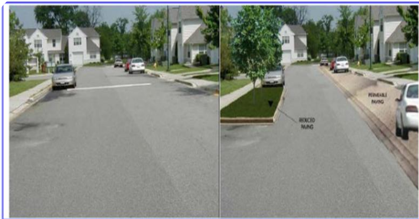
Εικόνα 32: Παρέμβαση σε οδό (πριν και μετά) για μείωση ταχυτήτων και κατασκευή ΒΕΤ Πηγή : U.S. ARMY CORPS OF ENGINEERS, 2004
